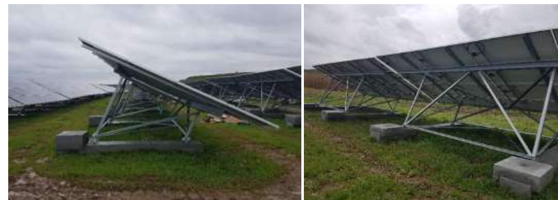
Figure 12 : Exemple de fondations béton (source : RES S.A.S)
