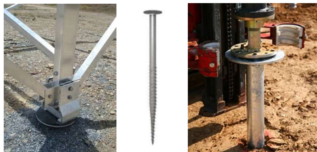
Figure 11 : Fondations à visser (source : RES S.A.S)
