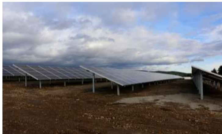
Figure 22 : Exemple d'espace non empierré entre tables (source : RES S.A.S)
